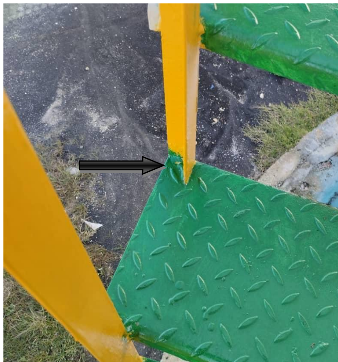
Figura 3.9 Área de acumulación y depósito reforzada con pintura y con cera impermeabilizante abrillantadora
