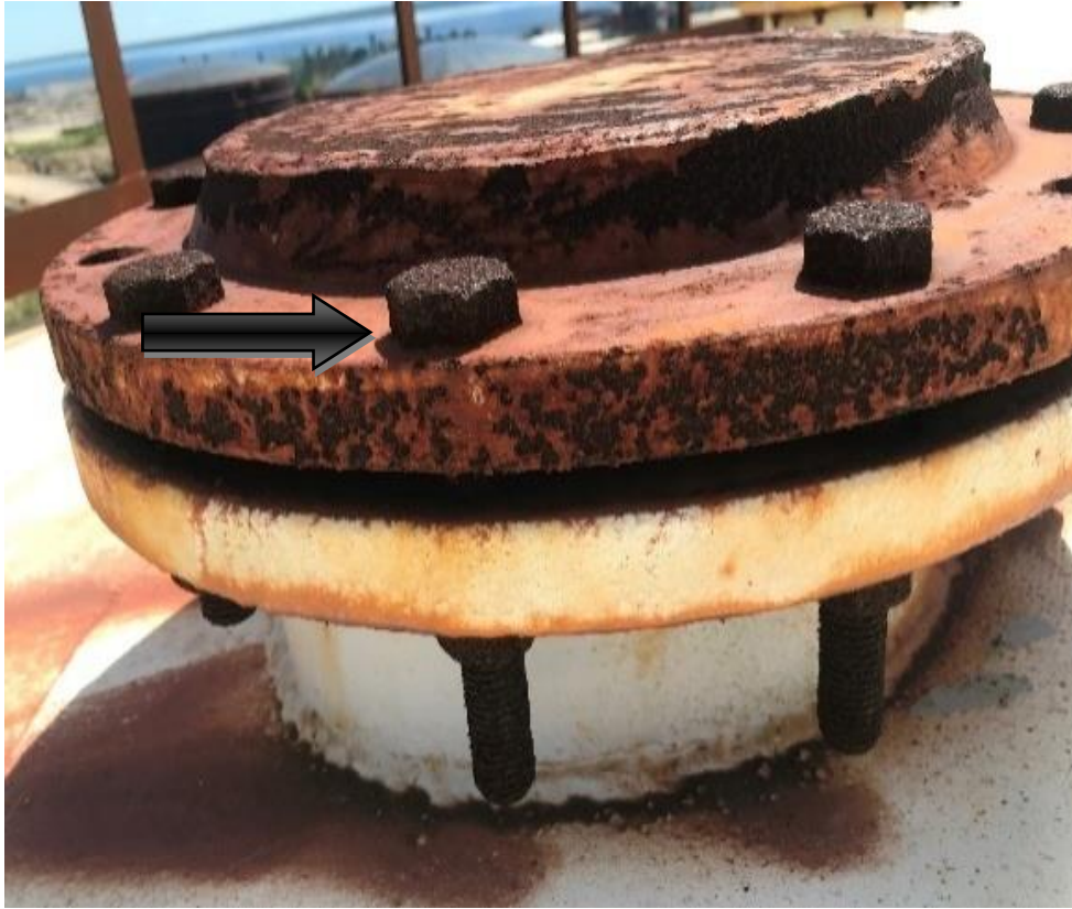
Figura 2.6 Espacio entre las 2 bridas menor de 50 mm. Resquicios entre el perno y la brida
