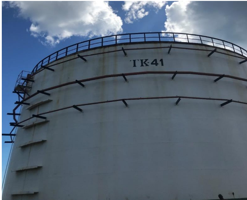
Figura 2.1. Tanque 41 de la Empresa Comercializadora de Combustible.
