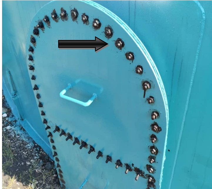
Figura 3.2.1. Pernos cubiertos con grasa semisólida de conservación
