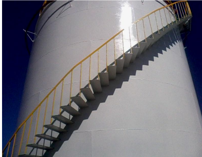
Figura 3.6. Superficies del tanque cubierta por cera abrillantadora
