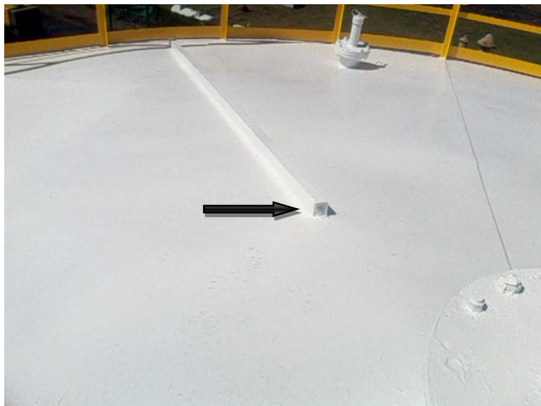
Figura 3.5. Componente hueco atomizado con grasa de conservación líquida y sellado con mástique
