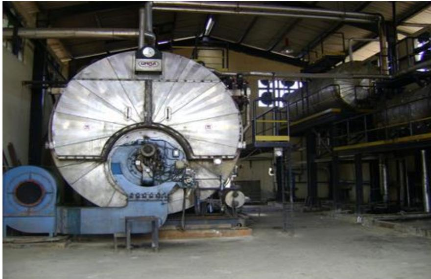
Figura A.2 a-) Generador de Vapor pirotubular de la Dirección Territorial de Combustible de Matanzas (DTMC). Fuente: (León, 2011)
