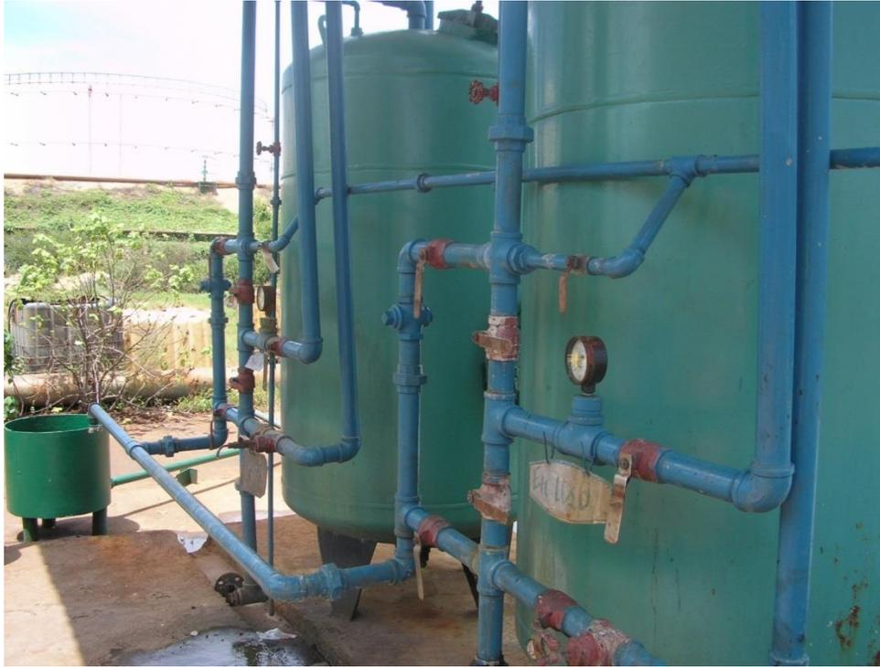
Figura A.2 c-) Suavizadores donde se realiza el tratamiento previo al agua de calderas, para eliminar su dureza total. Fuente: (León, 2011)
