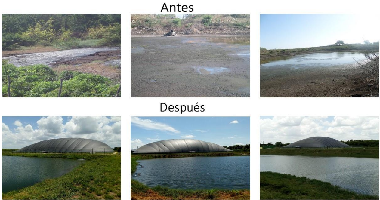
Figura B. Antes y después de la instatación del biodigestor
