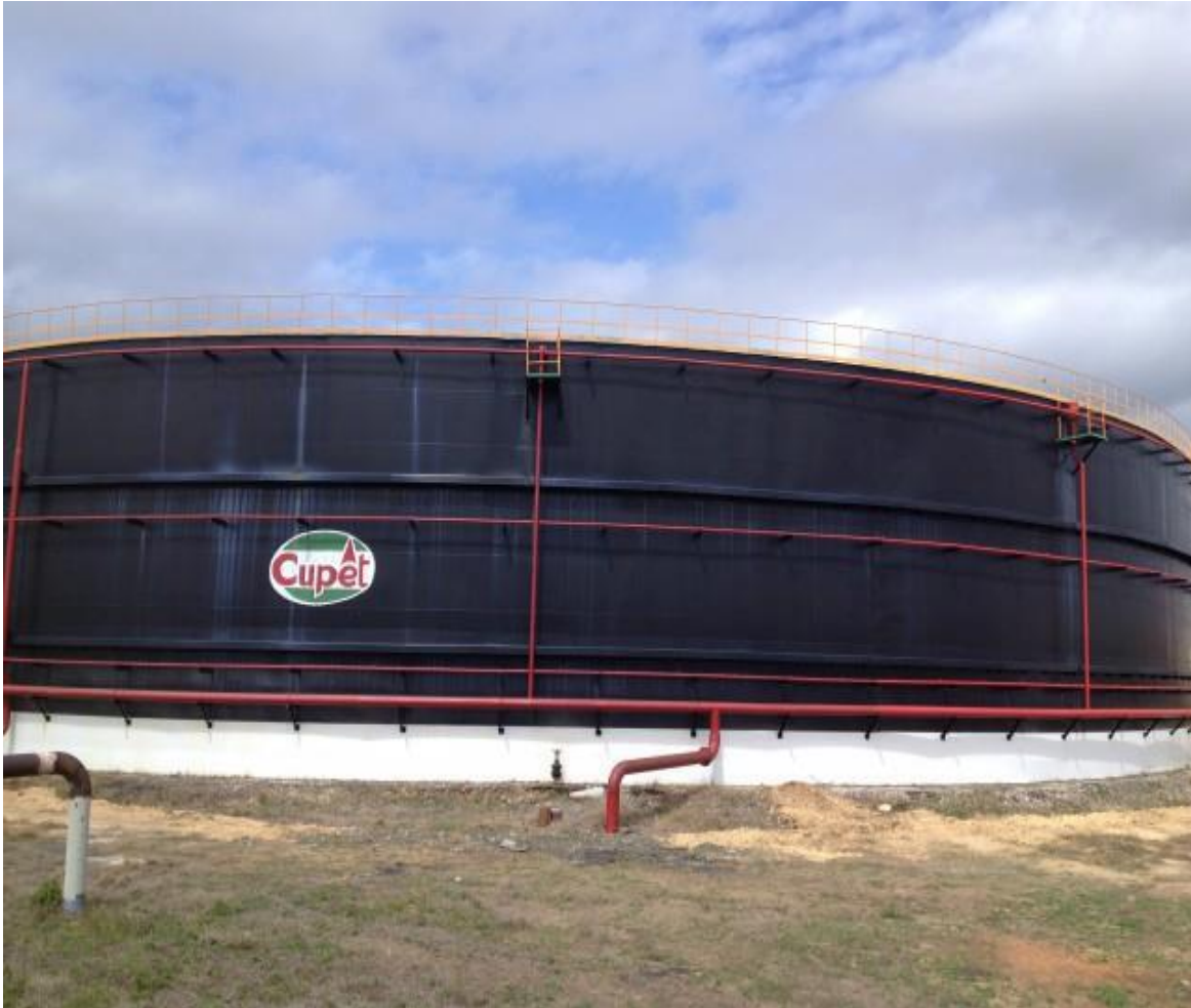
Anexo 4. Tanque 29 para el almacenamiento de petróleo crudo
