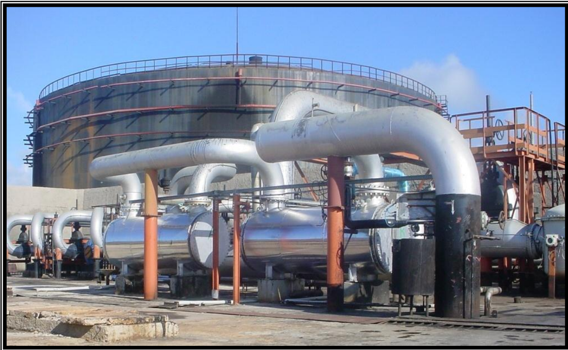
Anexo # 2. Estación de bombas 1-1
