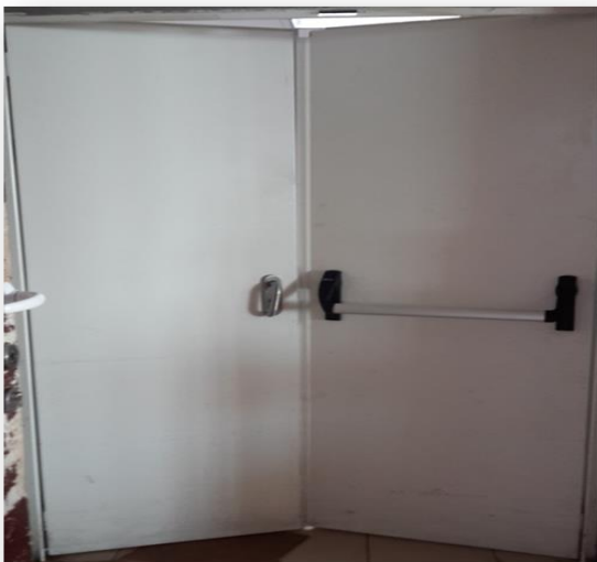
Figura 3.4. Puerta nueva del área de fregado
