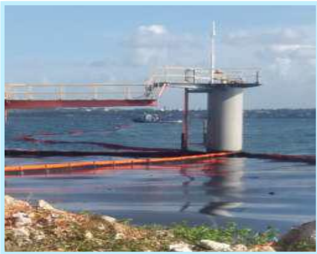
Imagen 2. Utilización de barreras oceánicas para la retención de crudo durante derrame.
