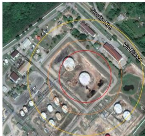
Figura 3.8 Alcance del accidente por charco de fuego en tanque 8
