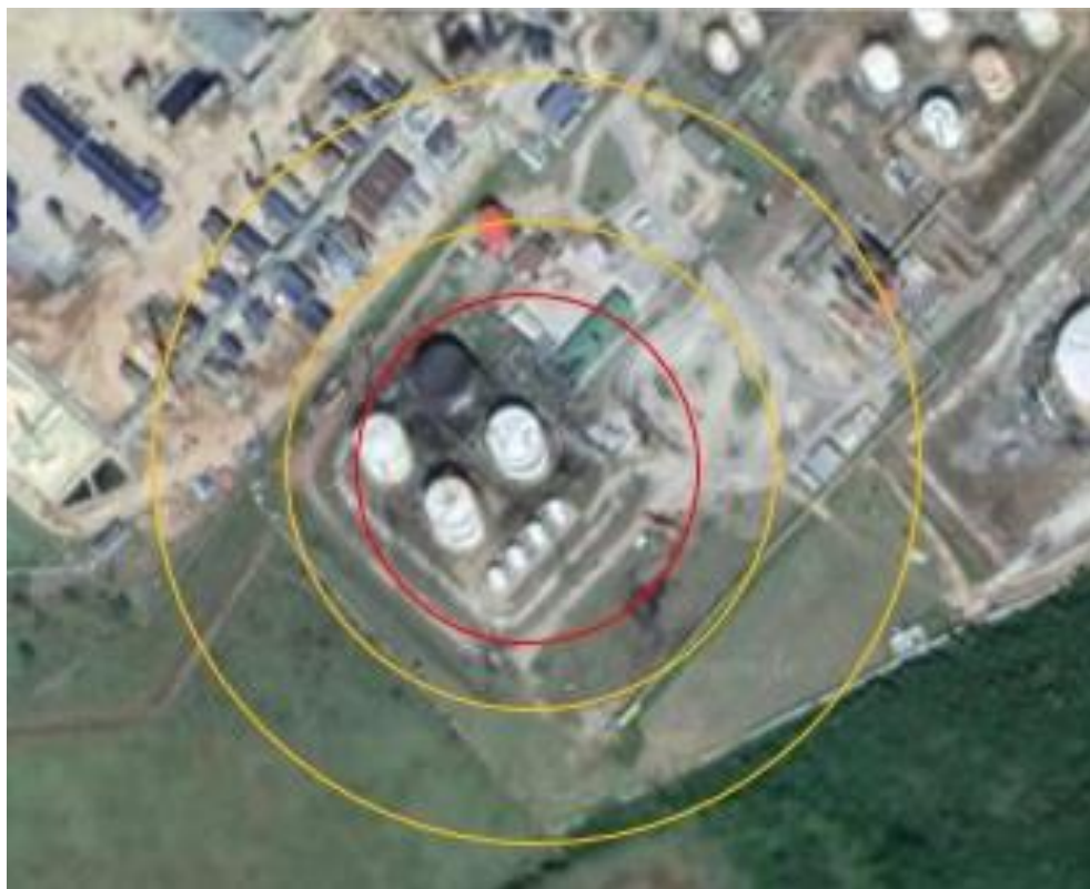
Anexo 27: Alcance del accidente por charco de fuego del tanque 101.
