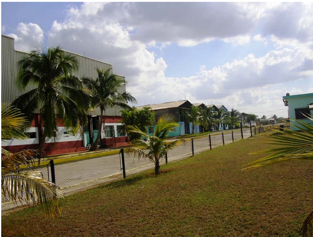
Vista Taller Metal mecánica
