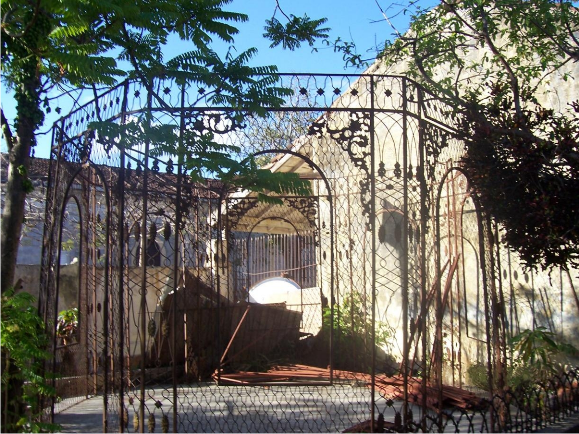
Pérgola ubicada en el patio del Museo Municipal “Juan Gualberto Gómez Ferrer”
