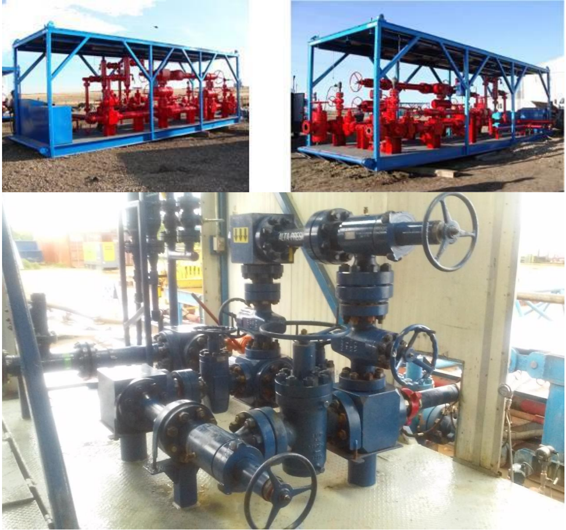
Figura A1.3 Ensamble de estrangulación
