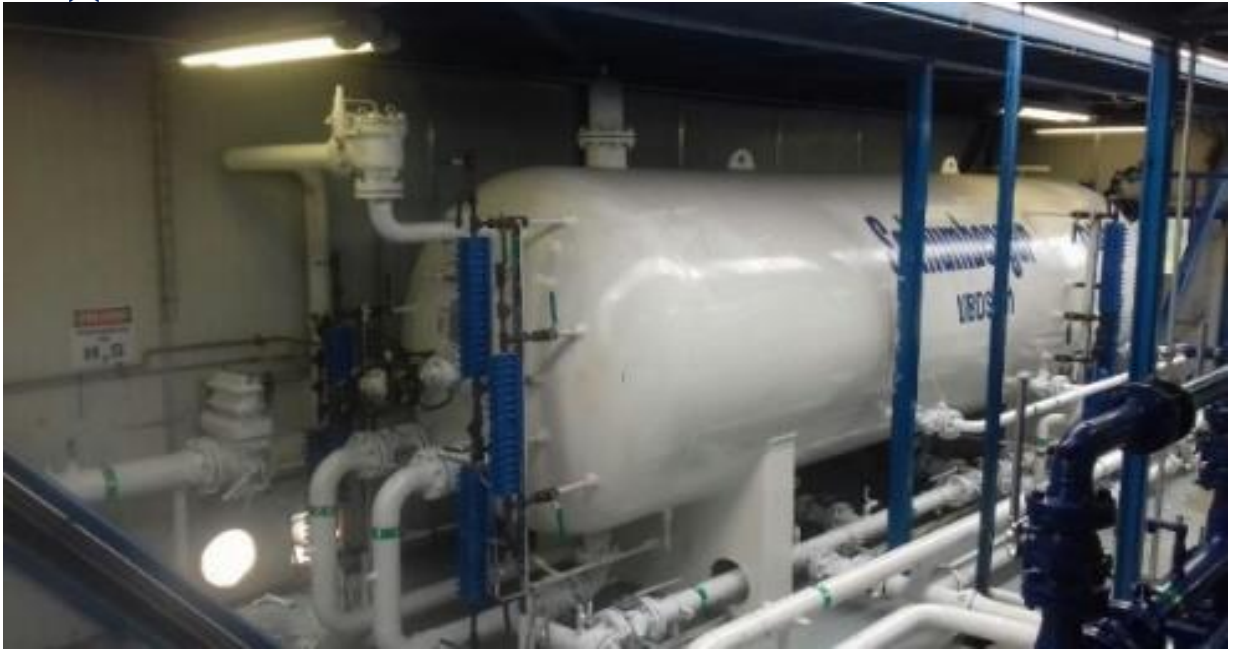
Figura A1.2 Separador horizontal de cuatro fases
