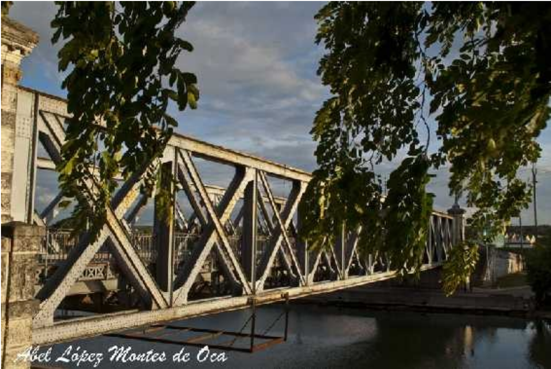
Celestino del Pandal participó en la edificación del puente Calixto García, del cual diseñó los estribos de cantería.
