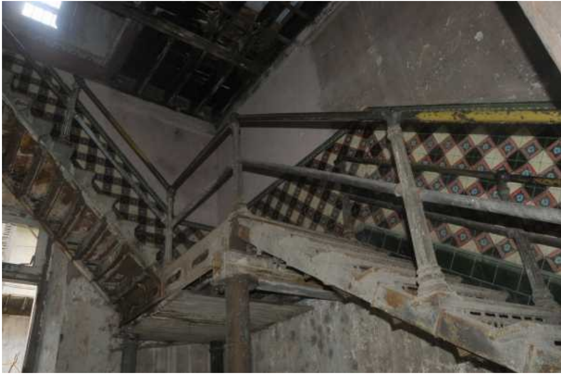
Escalera de hierro fundido, Hotel París
