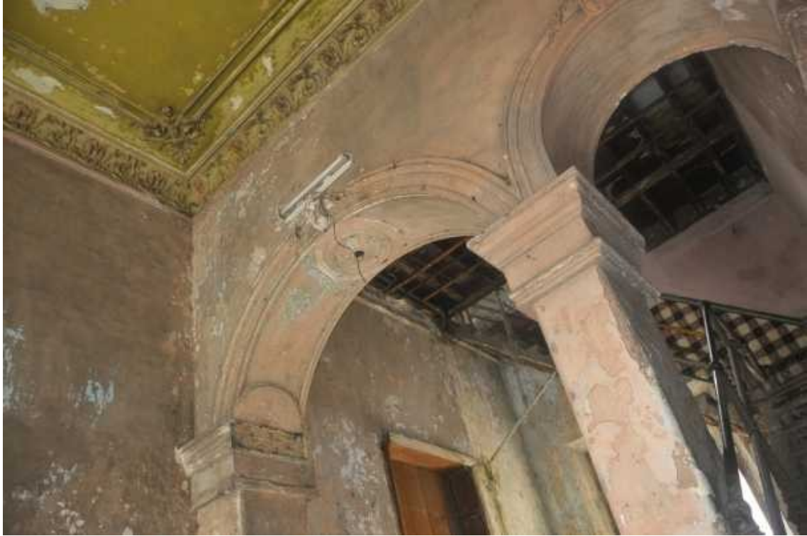
Columnas arqueadas, hotel París.
