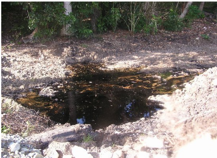
Fig. 3.16 Acumulación de petróleo producto de una avería.
