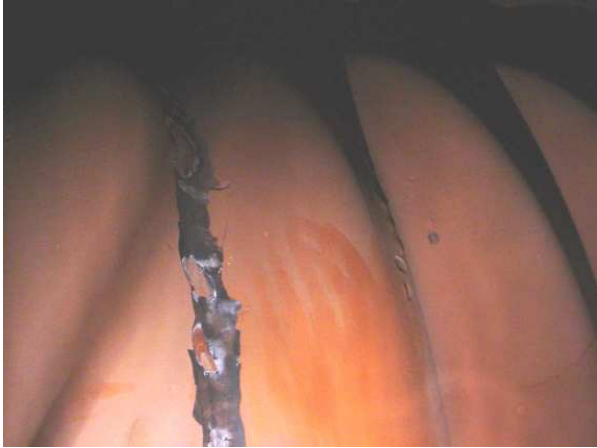
Fig. No 1 a-) Imagen del Interior de la caldera, afectada por el pH ácido, antes de la limpieza química.
