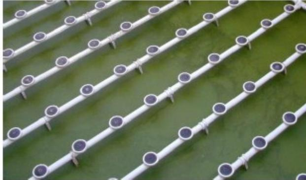
**Fig.2.7 Red de tubería y difusores del sistema de aireación del reactor biológico.**
