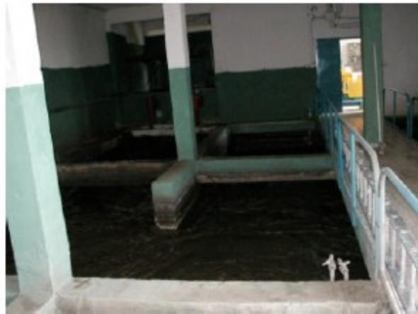
**Fig.2.4 Imagen de dos de las tres secciones del reactor biológico**
