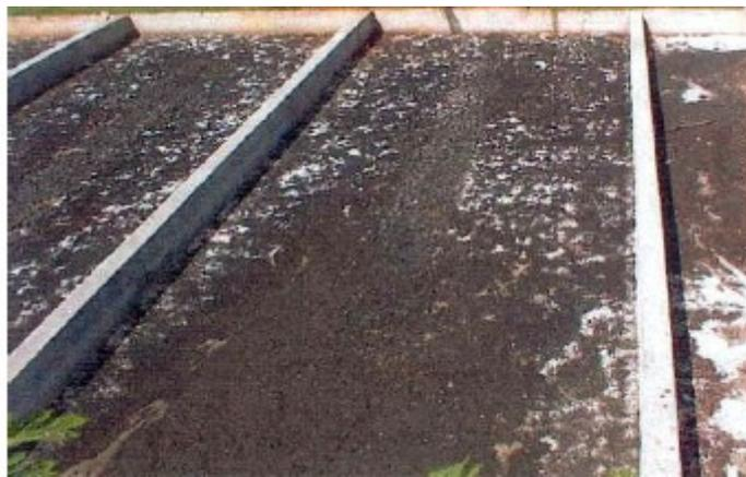
**Fig.2.9 Lechos de lodos de secado**
