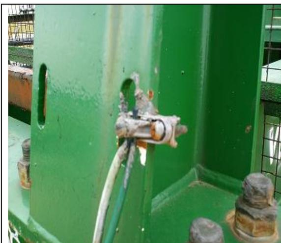
Fig.7 Presilla que sirve de unión al aterramiento.
