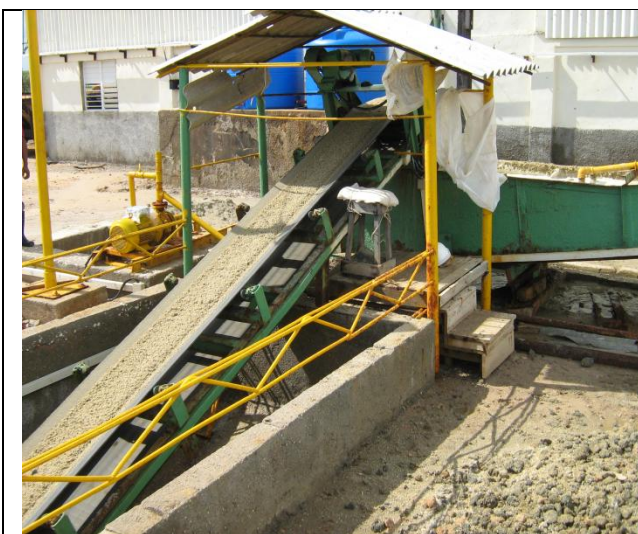
Fig. 22 Estructura de recepción y lavado. Vista frontal.
