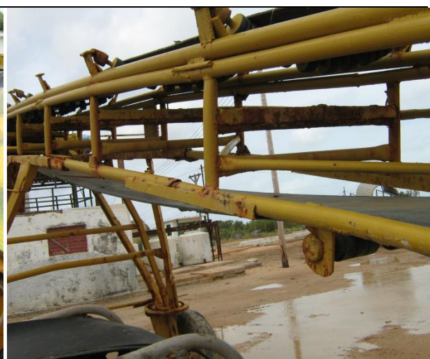
Fig. 10. Transportador a bandas tubular de los empleados en la empresa.
