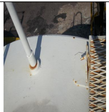
Figura 2.5 Respiradero del tanque de combustible
