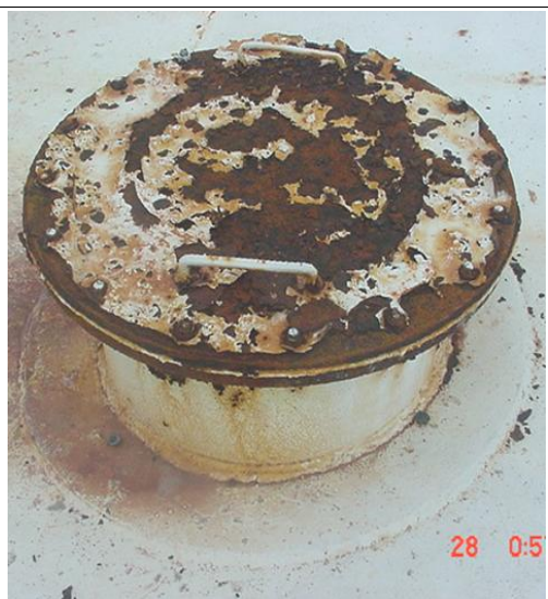
Figura 2.2 Registro en el techo.
