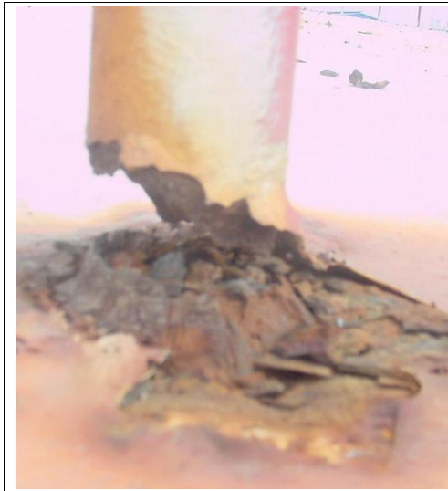
Figura 2.5 Unión de la baranda con el techo.
