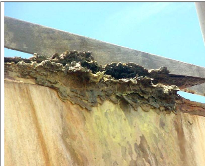
Foto.11 Falta hermeticidad de la soldadura de unión envolvente-techo. (Corrosión rotura por tensión interna) y/o rotura por hidrogeno. Salidero peligroso
