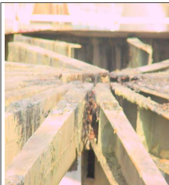
Foto.9 Columna central donde apoyan las vigas que soportarán el techo del tanque.
