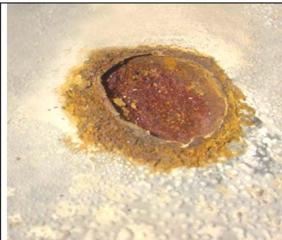
Foto.7 Corrosión localizada en el techo del tanque manifestada como ampollas
