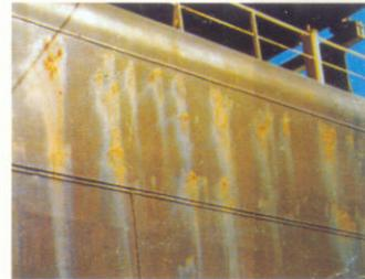
Fig. 3. Corrosiones prematuras debidas a la presencia de fragmentos de CALAMINA.
