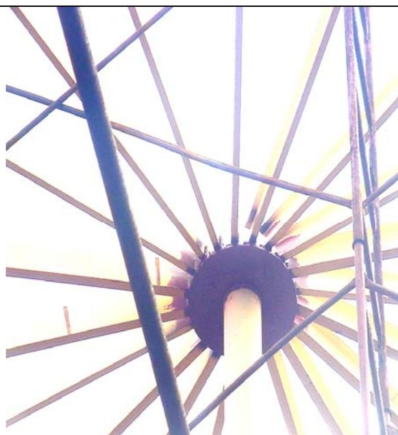
Foto.10 Columna central donde apoyan las vigas que soportarán el techo del tanque.
