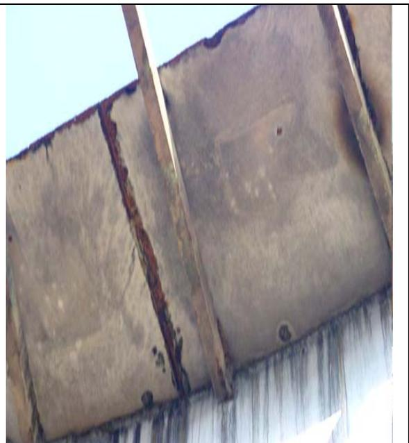
Foto.4 Corrosión en la plancha del techo en la zona apoyado sobre una viga (Celda de concentración) (Corrosión bajo depósito).
