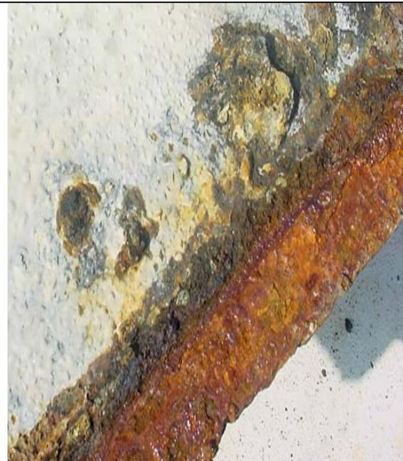
Foto.6 Corrosión detallada en la plancha del techo en la zona de apoyo sobre una viga (Celda de concentración) (Corrosión bajo depósito).
