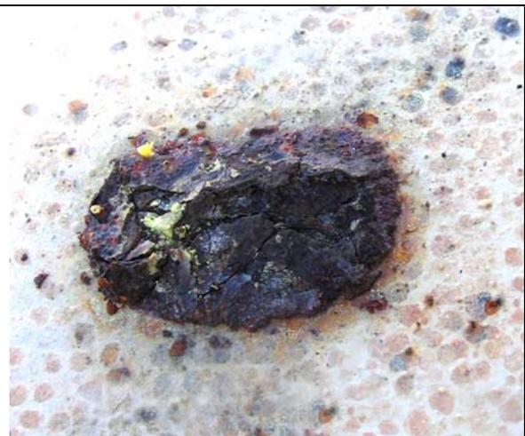
Foto.8 Corrosión localizada en el techo del tanque manifestada como ampollas
