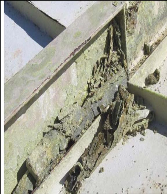
Foto.1 Acumulación de azufre en vigas I donde van apoyados los techos. (Corrosión bajo depósito).
