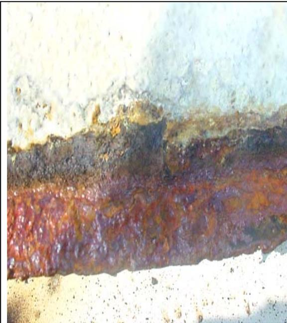
Foto.5 Corrosión detallada en la plancha del techo en la zona de apoyo sobre una viga (Celda de concentración) (Corrosión bajo depósito).
