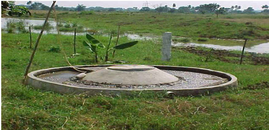
Figura 1.3. Biorreactor de campana flotante.
