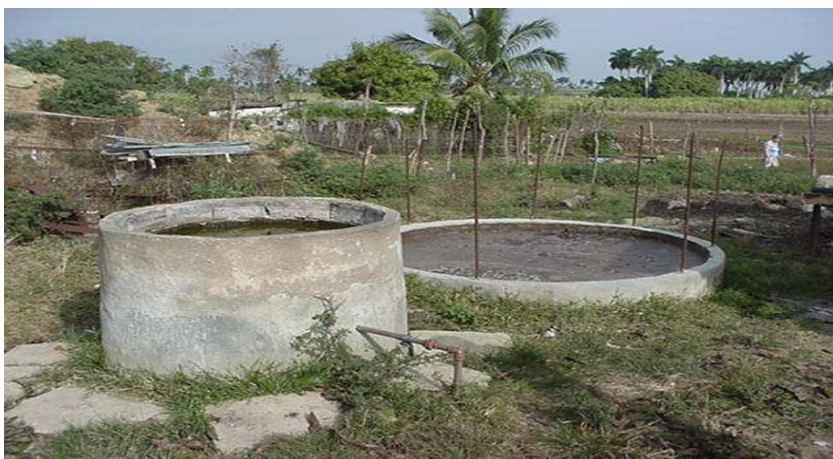
Figura 1.6. Biodigestor de 22.5 m 3 en Cantel.
