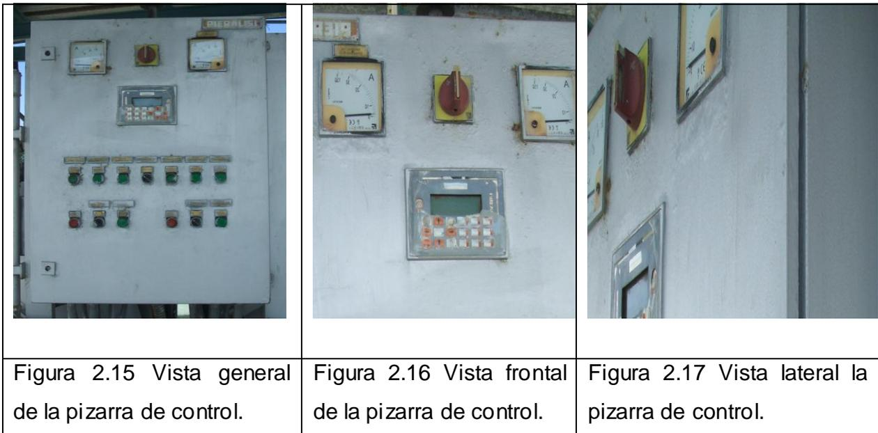
El la figura 2.17 se puede observar problemas con los bordes, además de las celdas de aireación diferencial por la mala preparación superficial antes de pintar.
