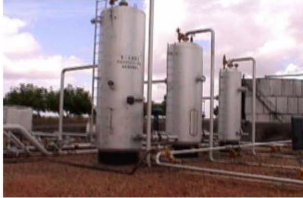
*Figura 1.7 Tren de separadores (separadores de alta presión, de baja y de prueba)*
