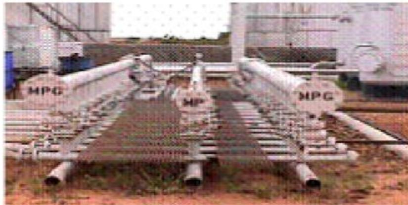
*Figura 1.5 Múltiple de Producción de una estación de flujo*
