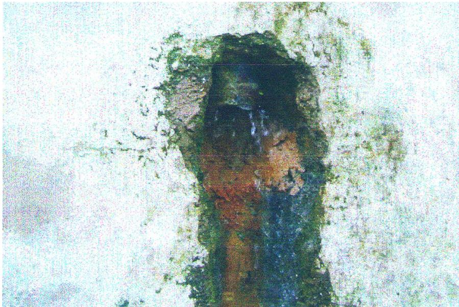
Figura 3: Salideros en tuberías rotas
