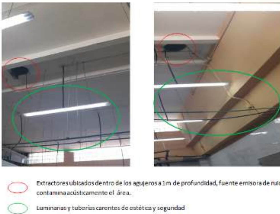
Figura 3.6. Techo del área de fregado de la cocina central
