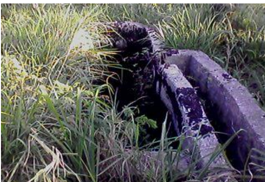
Figura 5 y 6: Tratamiento primario en mal estado.
