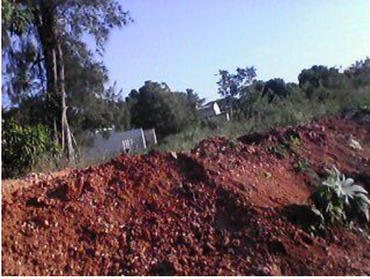
Figura 12: Deslizamientos de terrenos.
