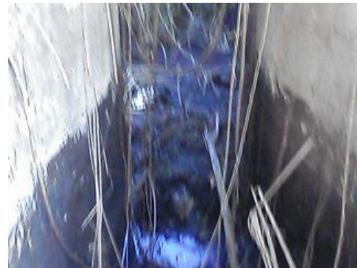
Figura 1 y 2: Registro y conductos cubiertos de hierba.
