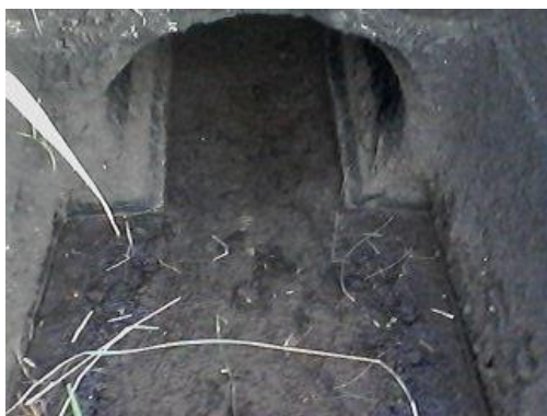
Figura 10 y 11: Ausencia de residuales en los conductos.
