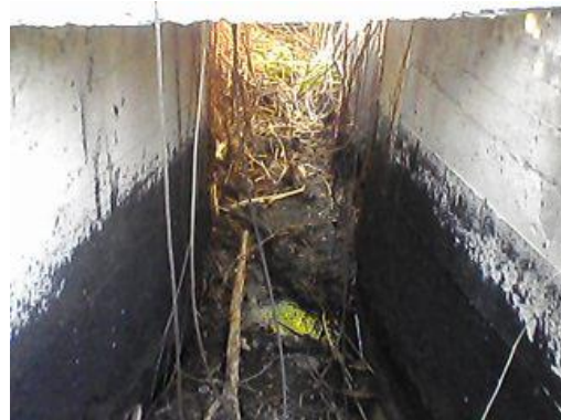
Figura 10 y 11: Ausencia de residuales en los conductos.
