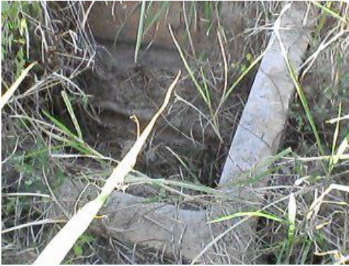
Figura 1 y 2: Registro y conductos cubiertos de hierba.
