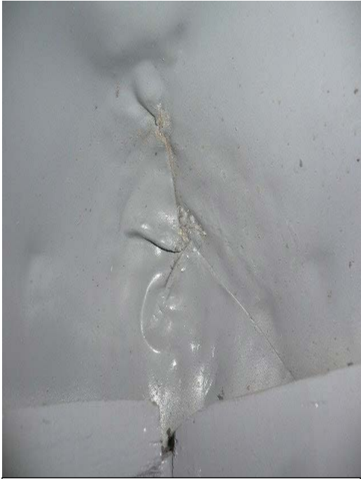
Fig. 41 Imperfecciones de soldadura y resquicio. Corrosión por celdas de aireación diferencial e intersticial.
