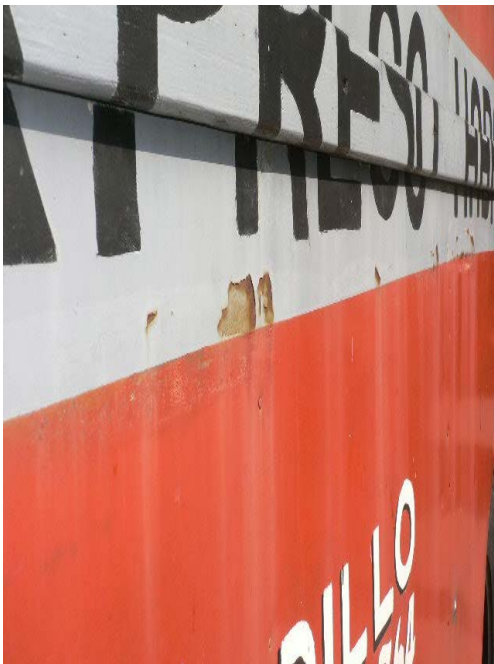
Fig. 31 Mala preparación superficial. Corrosión interfacial
