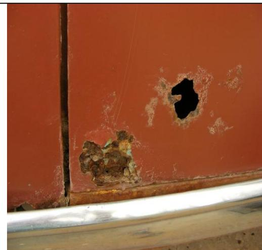
**Fig. 16** Mala preparación superficial en la estructura de acero. Presencia de corrosión por picadura, corrosión intersticial e interfacial.
