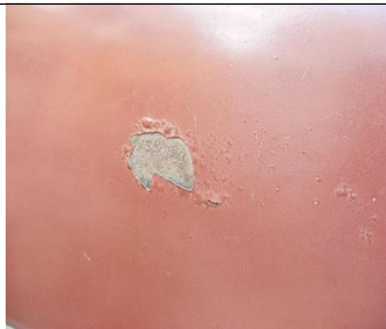
**Fig. 9** Problemas en la preparación superficial en la estructura de acero al carbono. Corrosión interfacial.
