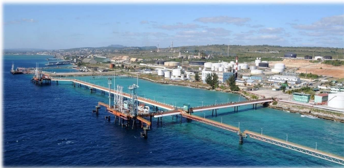
Figura 2.1. Fotografía de la ubicación de la empresa Comercializadora de Combustibles, Matanzas.
