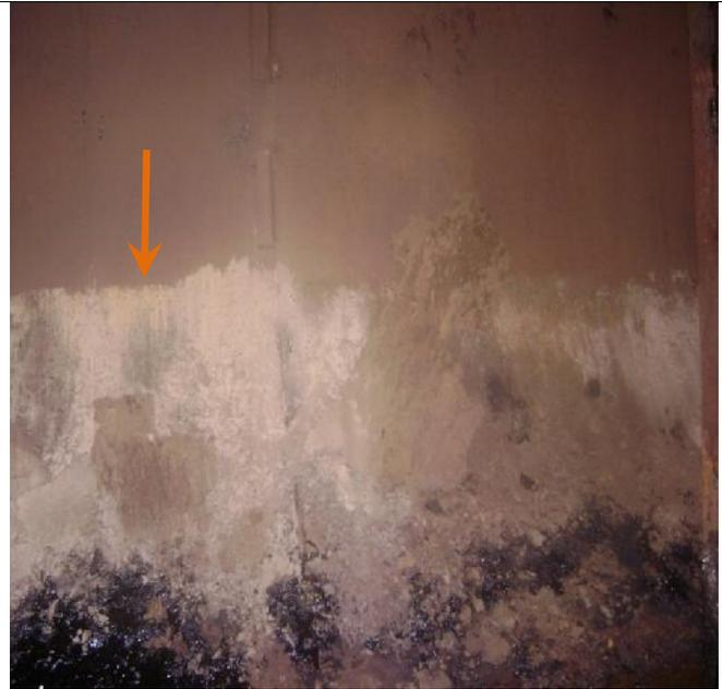
**Fig. 16: Pared lateral del separador horizontal de medición cercana al fondo, se evidencia la coloración blanca por la decantación de sedimentos y del agua que se acumulan (flecha naranja).**
