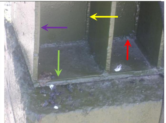
Fig. 6: Zona de acumulación de depósitos y humedad (flecha verde), bordes (flecha violeta), soldaduras irregulares (flecha amarilla), presencia de resquicios e intersticios (flecha roja). Se presenta la corrosión electroquímica atmosférica, húmeda y mojada, corrosión en resquicios.
