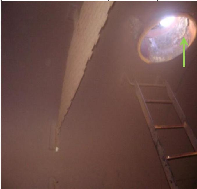
**Fig. 17: Vista de la boquilla de salida del gas, presenta productos de corrosión química (cascarilla) y desprendimiento de material (flecha verde).**
