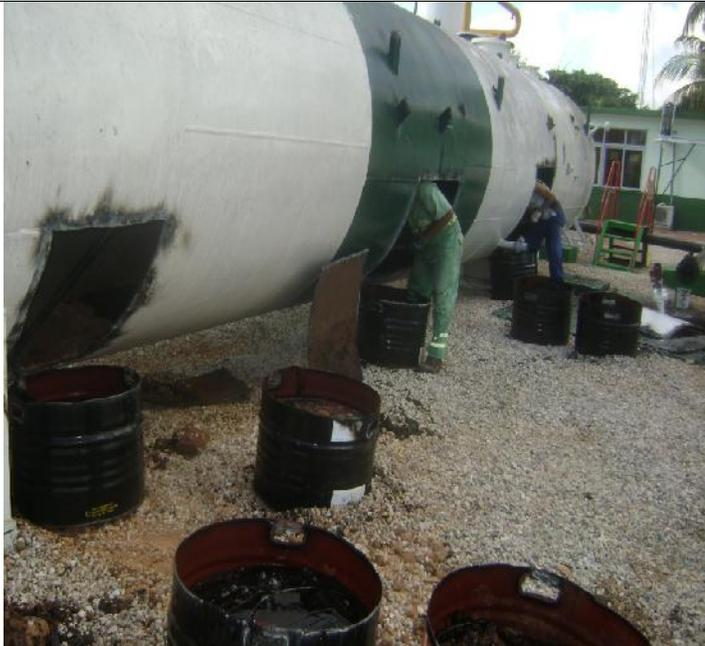
**Fig. 11: Separador horizontal de medición del CC-1 al que se le abrieron las ventanas para su accesibilidad.**
