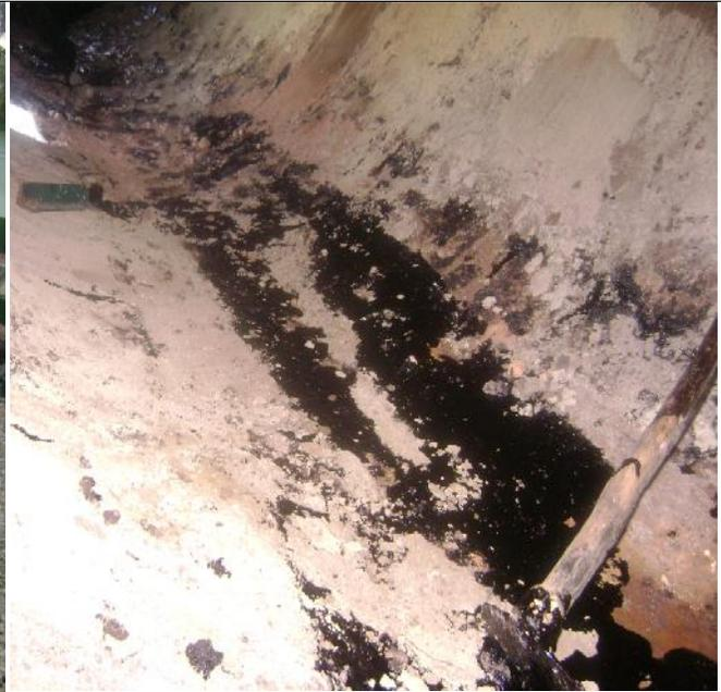
**Fig. 12: Vista interior del separador horizontal de medición una vez limpiado.**
