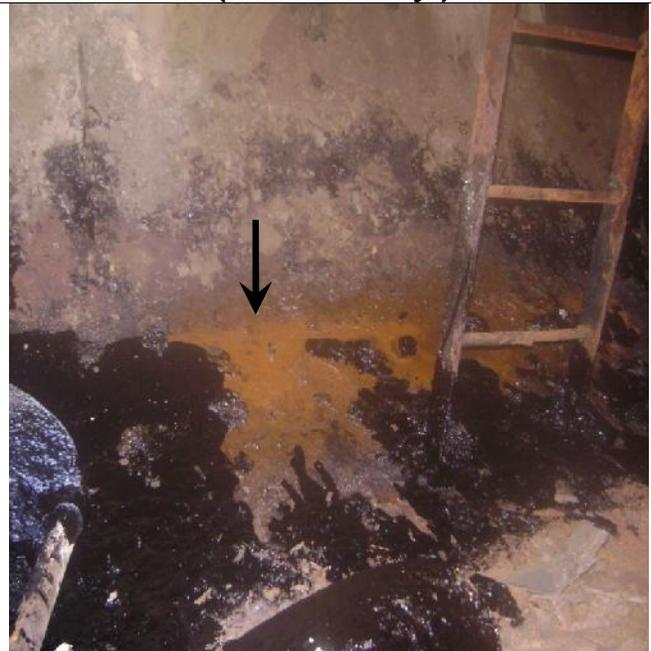
**Fig. 18: Franja inferior del separador horizontal de medición, donde se observan productos de corrosión de color pardo-rojizo (flecha color negro).**
