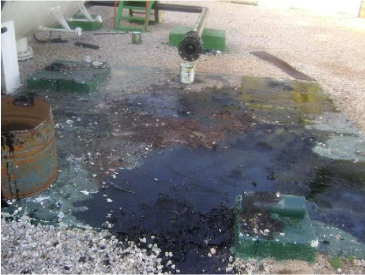
**Fig. 19: Contaminación que se produce por la limpieza interior del separador.**
