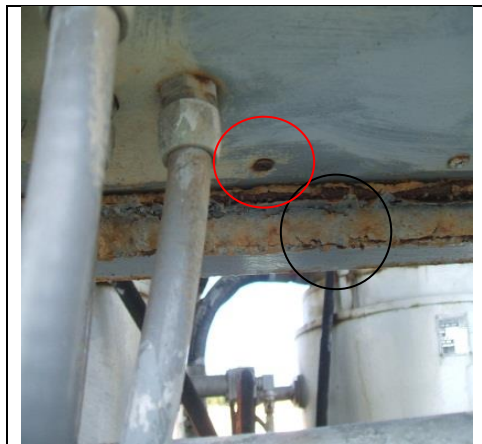
Figura 2.25 Parte inferior de la pizarra de control.
