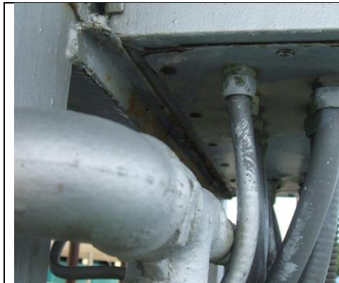
Figura 2.24 Difícil acceso en la pizarra de control.
