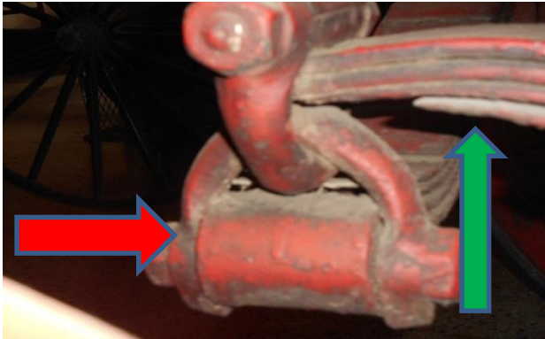
Fig.4 Resquicios, pernos (roja), acumulación de depósitos y humedad (verde).Presenta corrosión electroquímica atmosférica húmeda y en resquicios
