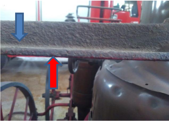
Fig. .11 Zona de acumulación de depósito (azul), bordes (roja). Presenta corrosión electroquímica atmosférica húmeda generalizada.
