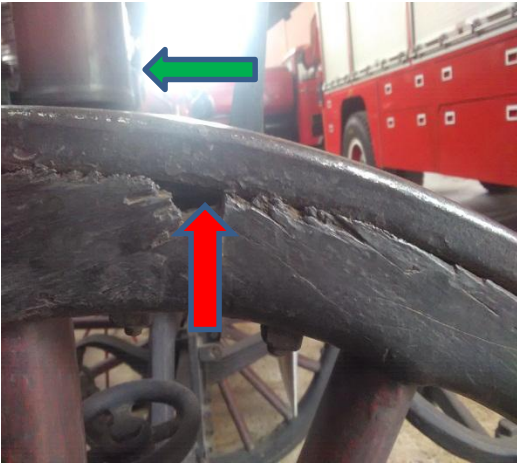
Fig. 14 Componente hueco (verde) resquicios (rojo). Presenta corrosión electroquímica atmosférica húmeda y en resquicios.
