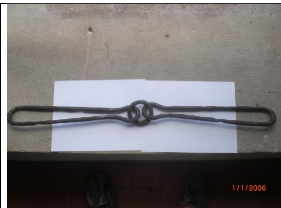
Fig. 33. Grillete. Presenta corrosión electroquímica atmosférica generalizada.
