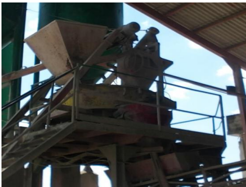
Figura A.9.3 Mezcladora de las materias primas para la confección de la mezcla de hormigón
