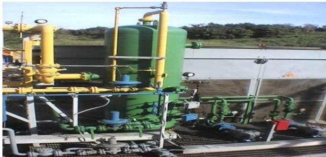
*Figura 2.6 Condensador de reflujo*
