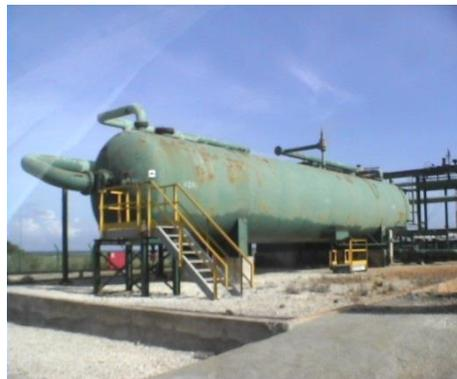
**Figura 2.2 Separador bifásico (V-2000)**
