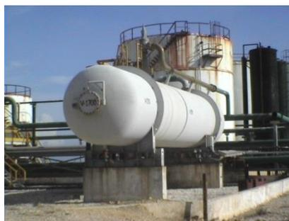
**Figura 2.1 Separador de Medición**
